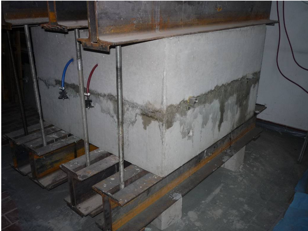
Bild 4: Prüfbehälter bei einem Wasserdruck von 2,0 bar – Feuchtestellen
